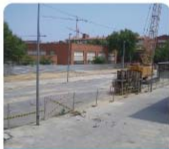
A finales de junio empezaron las obras de la estación de Metro
